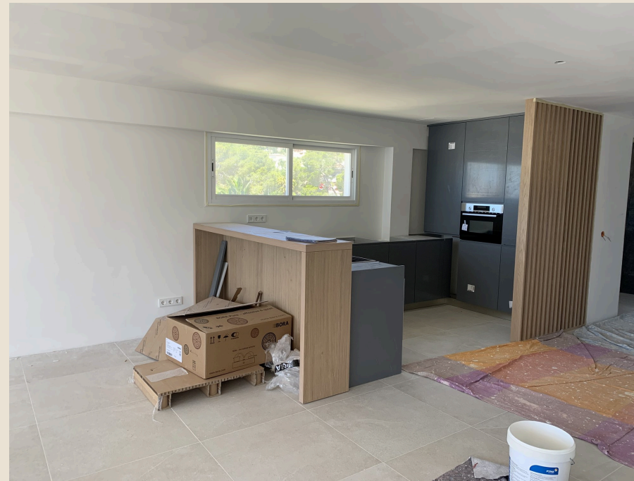
Montaje de la cocina
