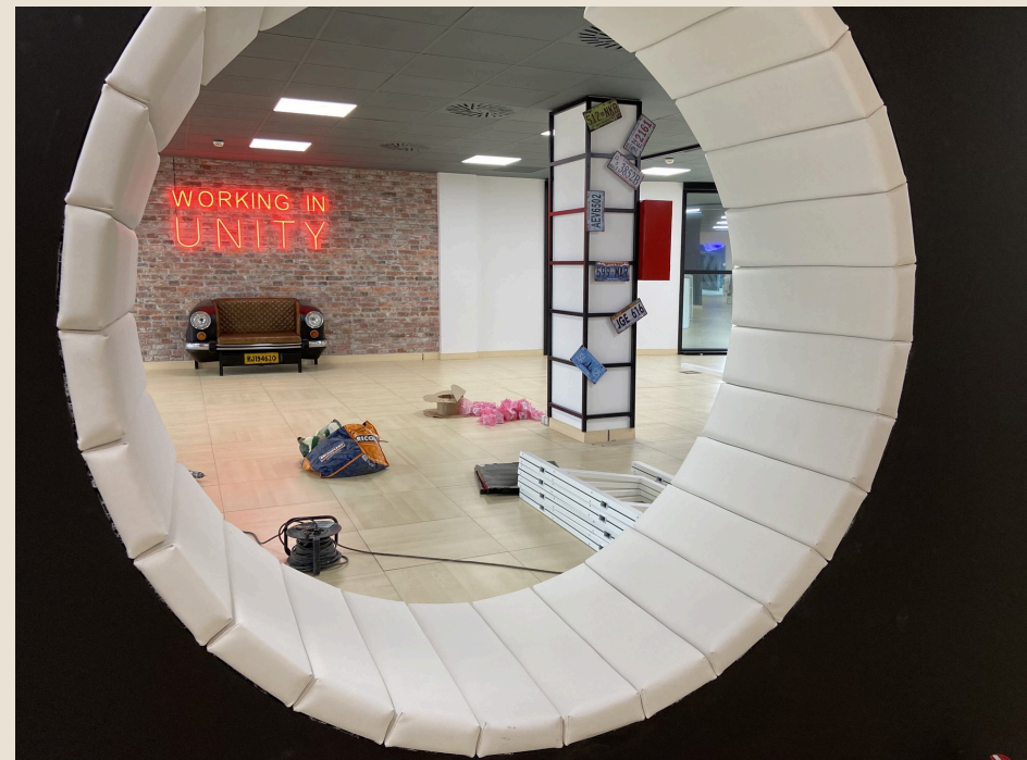
El portal circular, recién instalado
