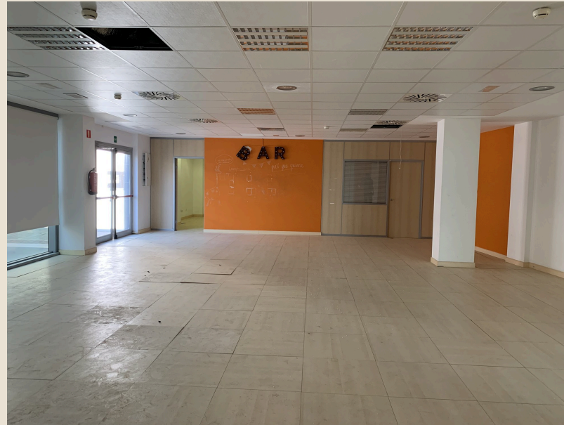
La planta, antes de empezar
