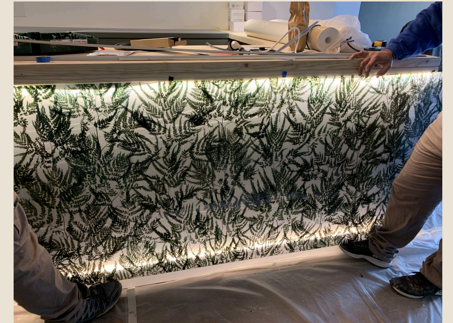
Montaje del panel retroiluminado de la barra
